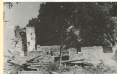
Stan kościoła w Oborze w początkowej fazie odbudowy po zniszczeniach wojennych.
